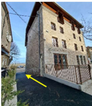
Accès par le devant de l'immeuble
