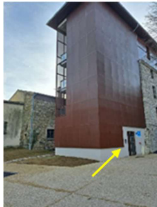
Accès par le parking à l'arrière du bâtiment
